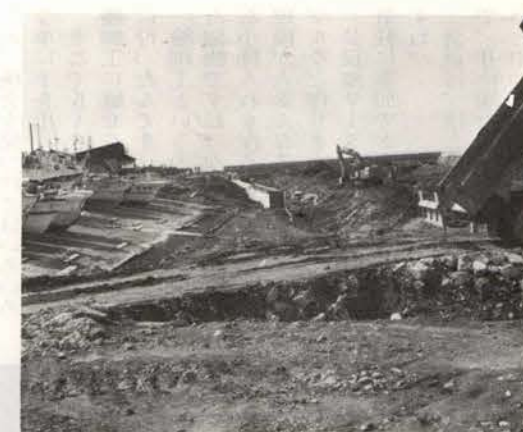
▲礼受漁港改修事業 近年、漁船の大型化にともない漁港の泊地水深が浅くなったため、浚渫工事を行なっています。10月中の完成です。
