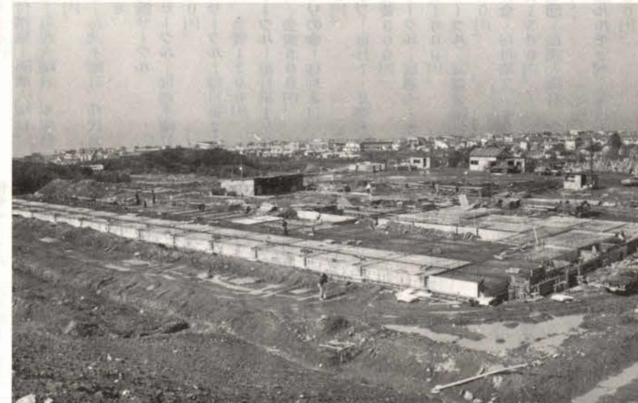
▼特別養護老人ホーム 施設の規模は、収容人員50名、鉄筋コンクリート平屋建て、居室13室を始め静養室、機能回復訓練室など1409平方mの建設が進行中です。
