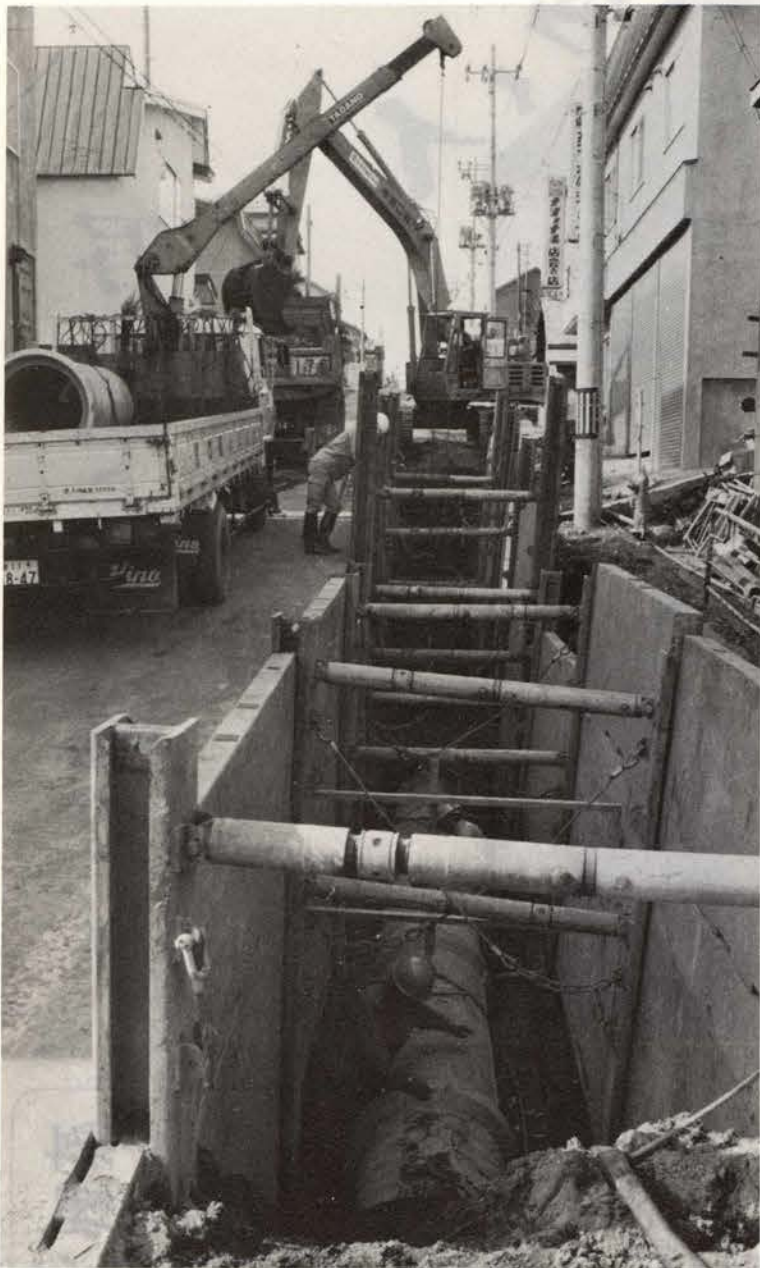
▲下水道事業 同事業は、本年も汚水雨水管の埋設工事が進められています。工区は建設協会～留萌小までの延長 170m (雨水管) と市道南7丁目通りの宮園町2丁目～幸町4丁目までの延長 2.7km (污水管) に着手しています。
