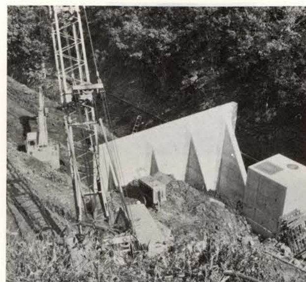
▲浜中塵芥処理施設 現在の沖見町沢の捨場が限界となったため、浜中に移転します。来年3月完成を目指し搬入道、ゴミ流出防止施設などを建設しています。
