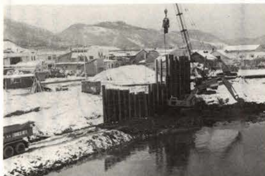
← 422メートルの護岸に着手
