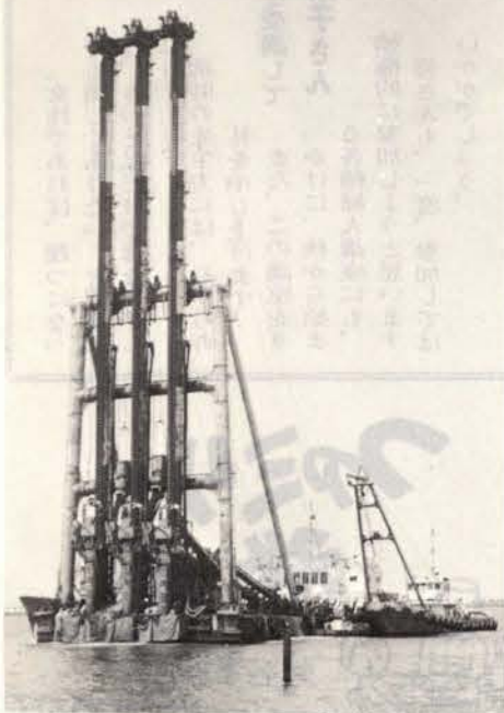
くい打ち船での古丹浜地盤改良工事
