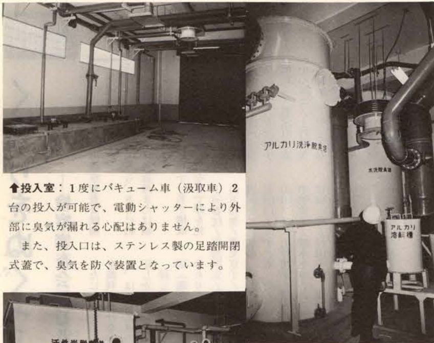
↑脱臭装置：三段式（水洗・アルカリ・活性炭）脱臭装置を完備しています。水洗脱臭塔は、投入室から発生した臭気を排臭ブローワーで吸引し、水洗により一部除去し、さらにアルカリ脱臭塔で脱臭し、最終脱臭を活性炭脱臭塔（左）により完全脱臭します。
