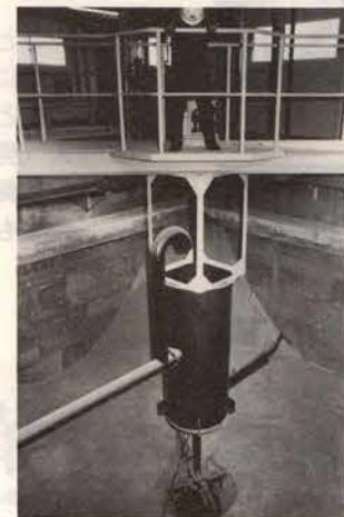
←沈澱槽：稀釈、曝気されたし尿は、スクリーンにより緩やかに上昇する際、汚泥や浮遊物を沈降、分離し上水を滅菌池に流出させる。
