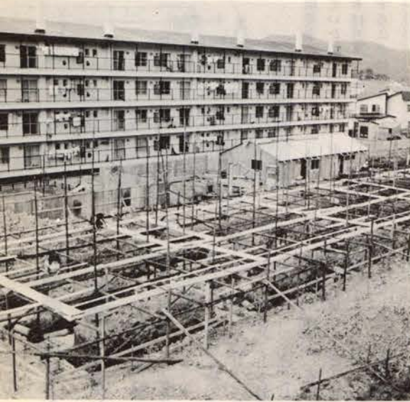
～道営住宅とともに建設が進む野本町団地～
