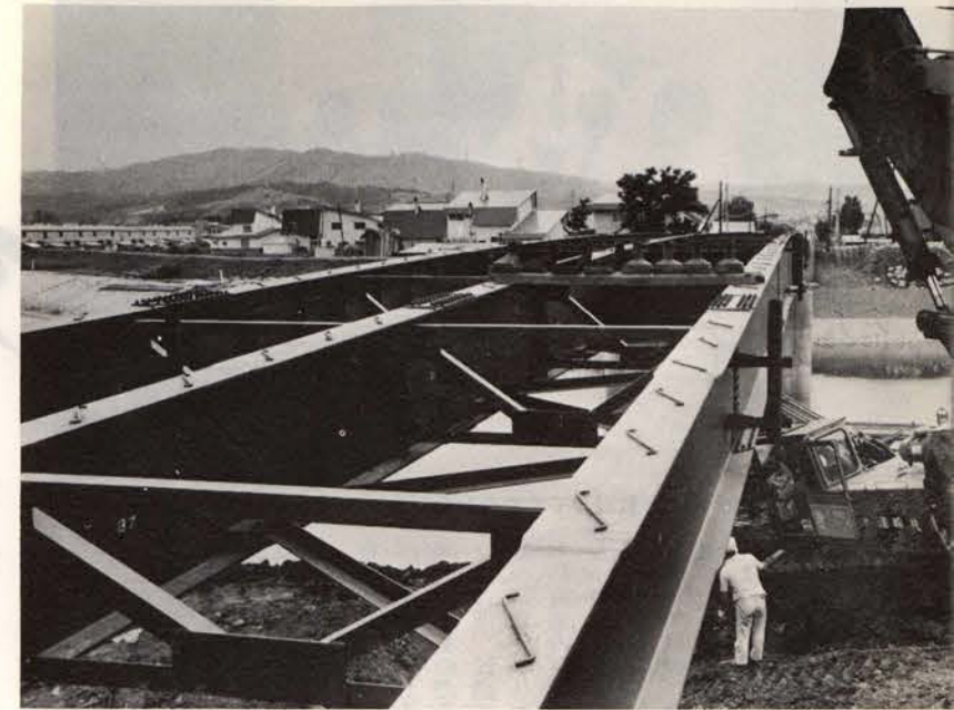
～大通り橋建設工事、も急ピッチで進められています～
