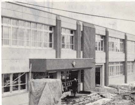
②第1期工事が完了した港南中学校
