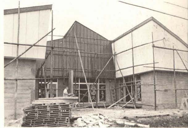
完成間近の港北保育所
