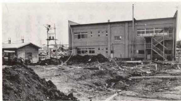
建設される所と福祉センター
