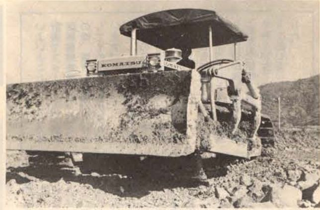
③幌糠地区を中心に、ほ場整備事業、山間にブル ドーザーの音が響きわたる。
