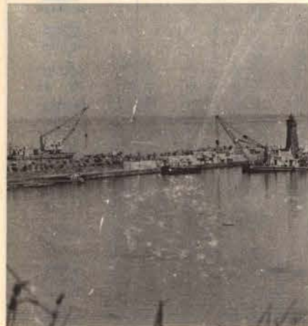
⑤開発建設部の手によって行なわれている 留萌港整備事業南防波堤を中心に延長工 事が進められている。
