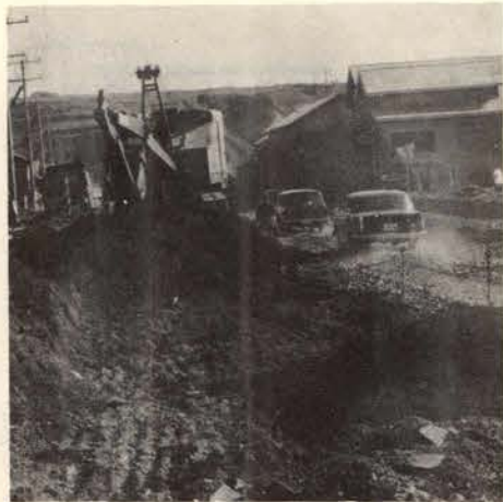
国道231号線(増毛~留萌)の延長18Kは昭和46年全間舗装完了を目標に……
