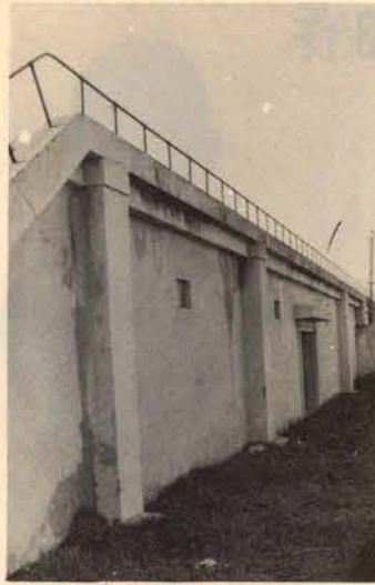
廃止される加圧ポンプ場
