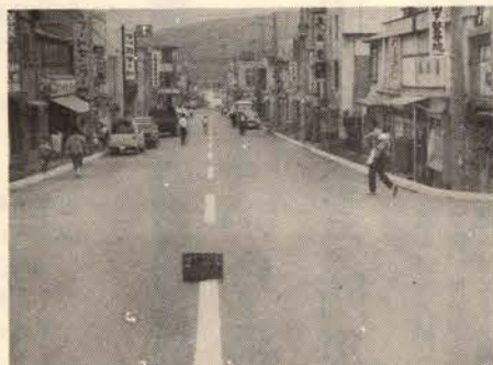
舗装の終わった拓銀横市道
