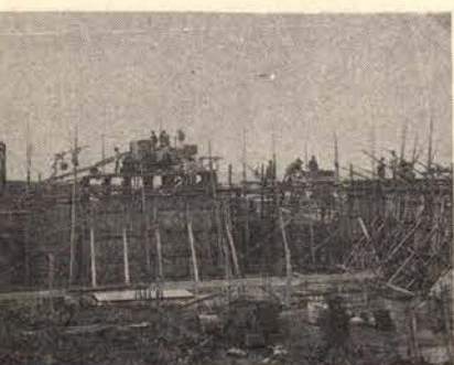
写真は配水池工事(昭和元年)
