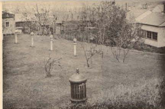
沖見町配水池の一部
