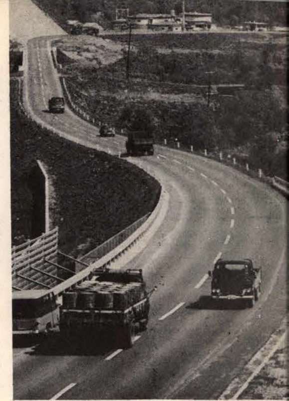
し尿処理場は大和田町国道のそばにある
