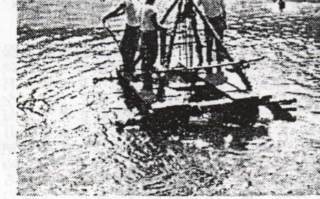
春日町地区への配 管工事は留萌川の 底を這って
