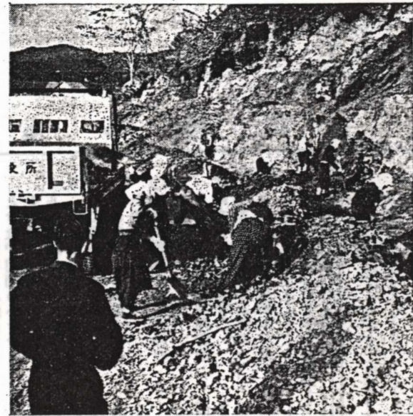
失業対策事業の一つである採石事業の現場。ここで採石された砂利を市内各所の道路補修に使用しています。
