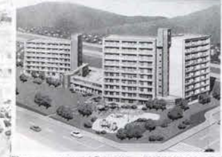
五十嵐町市営住宅
