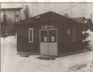
見晴市営球場公衆トイレ 照明自動点滅・自動換気・パナヘルター 一・手洗い・メロディー付・ペーパー ド・温水器洗面化粧台・多目的トイレ 総工費約700万円
