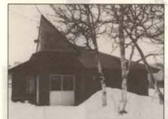
錦町公園公衆トイレ 照明自動点滅・自動換気・パナヘルター 一・手洗い・メロディー付・ペーパー ド・温水器洗面化粧台・多目的トイレ 総工費約1,680万円
