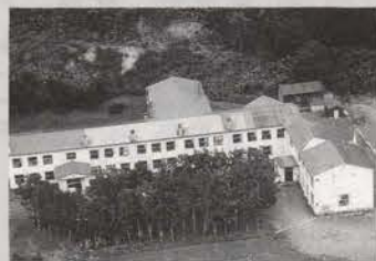
昭和35年に建設し、築38年が経過する校舎
