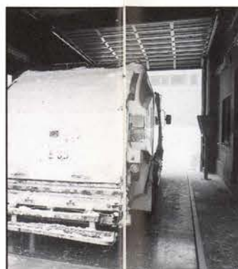
▲計量室 自動的にごみを計ります
