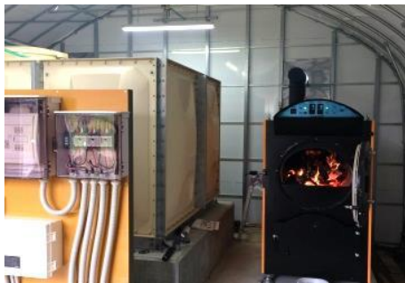
資源循環型バイオマス燃焼ボイラー（右） ボイラー内1次燃焼室（ガス化）と貯湯タンク（左）
