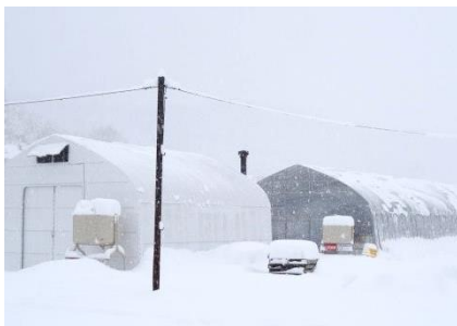
B棟（後方）と 資源循環型ボイラーハウス（手前）
