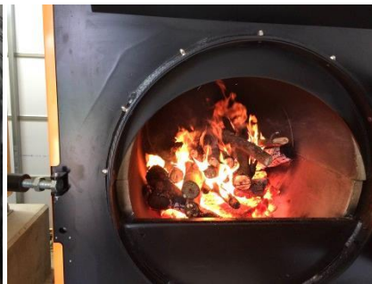
資源循環型バイオマス燃焼ボイラー（右） ボイラー内1次燃焼室（ガス化）と貯湯タンク（左）
